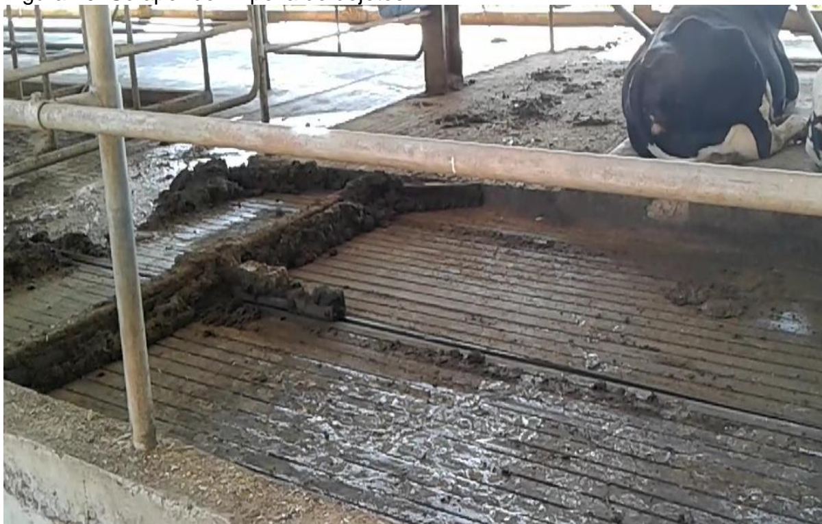
Figura 10: Scraper de limpeza de dejetos
