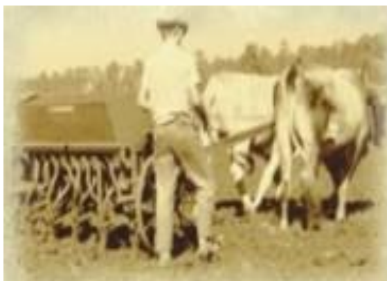
Figura 2. Semeadora-adubadora de 9 linhas com tração animal em 1960. Fonte: Fankhauser SA (2011).
