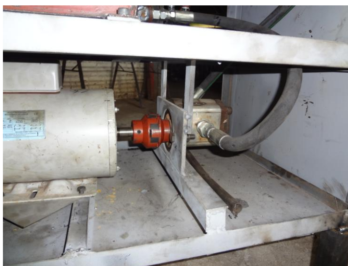
Figura 17 – Motor Elétrico e Bomba de engrenagens.
