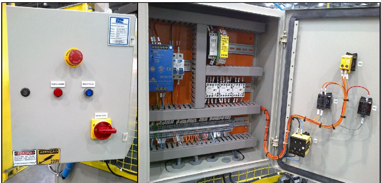
Figura 19: Proposta de painel elétrico conforme NR 12. Fonte: Zeta Tecnologia em Automação.
