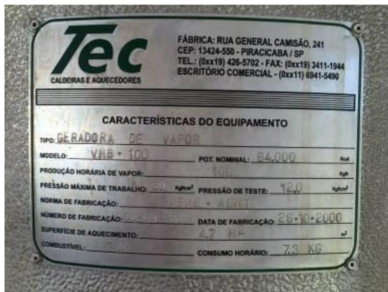
Como mostra a Figura 12, todo vaso de pressão deve ter afixado em seu corpo em local de fácil acesso e bem visível, placa de identificação indelével com, no mínimo, as seguintes informações (Norma Regulamentadora – NR 13):
