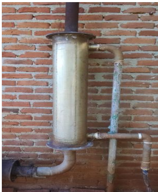
Figura 17 – Trocador de calor do tipo casco
