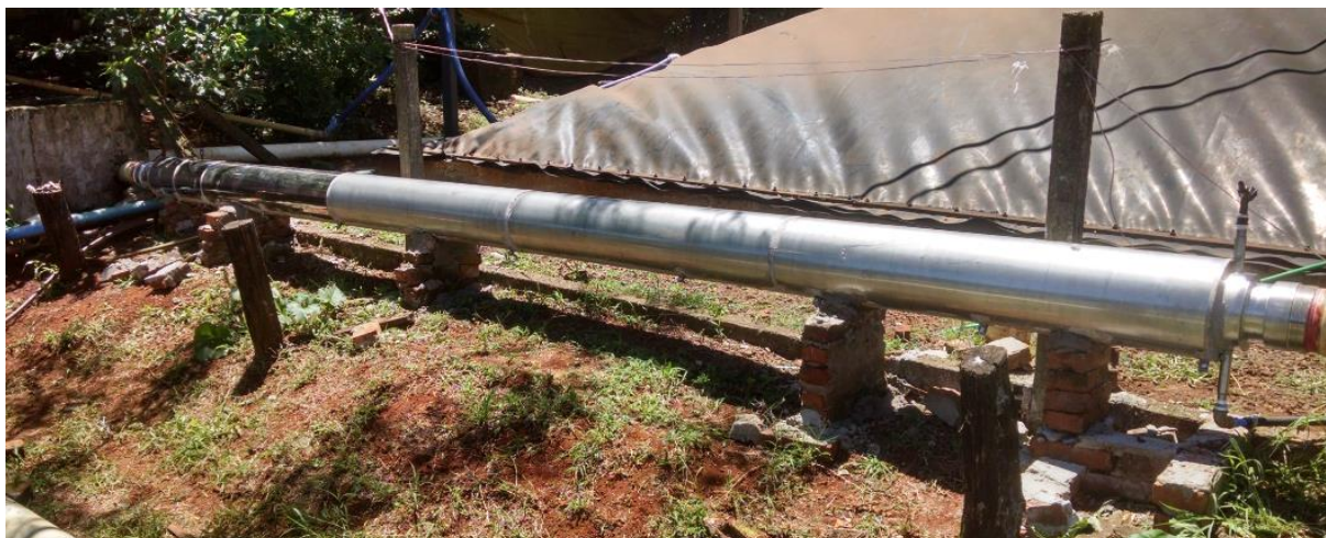
Figura 19 – Trocador de calor de tubos concêntricos
