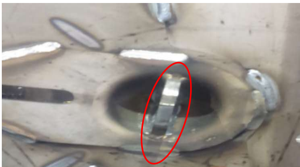
Figura 20: Tensor da correia desalinhado.
