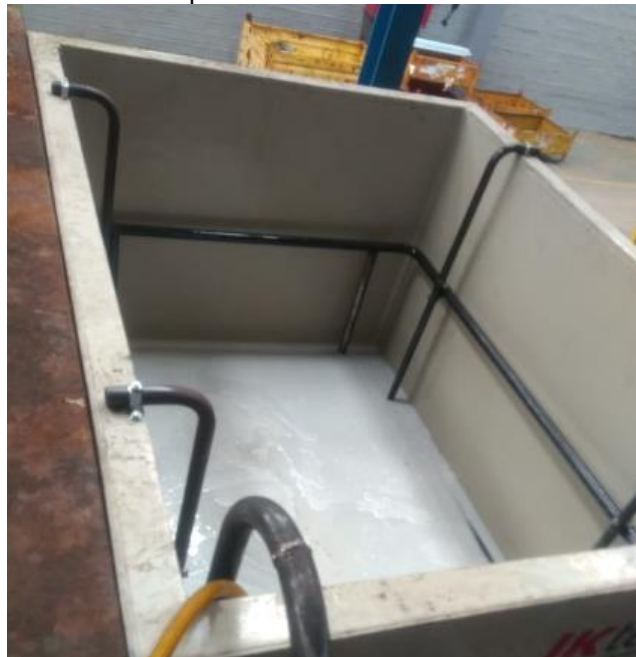
Figura 29 – Instalação do sistema de aquecimento
