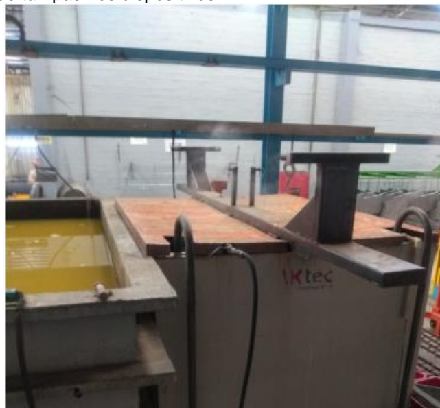
Figura 32 – Instalação de tampas nos dispositivos
