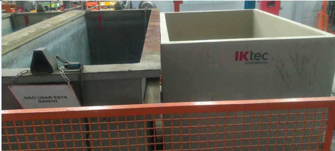
Figura 28 – Instalação do tanque
