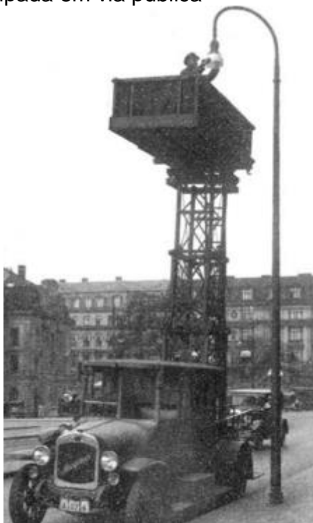
Figura 2 - Substituição de lâmpada em via pública
